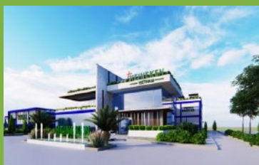
Dự án Heineken Vũng Tàu
